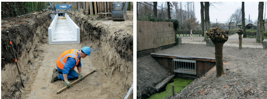
Figuur 7.4 Aanleg goot onder het trottoir (links) en instroom goot vanuit vijvers boven reguliere duiker (rechts).
